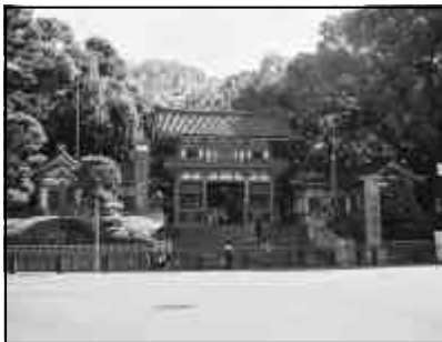
八坂神社 西楼門
