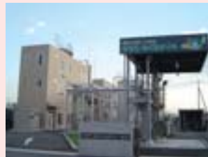
廃食用油燃料化施設
