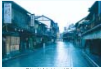
電線が地中化された花見小路
