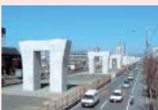
高速道路建設現場
