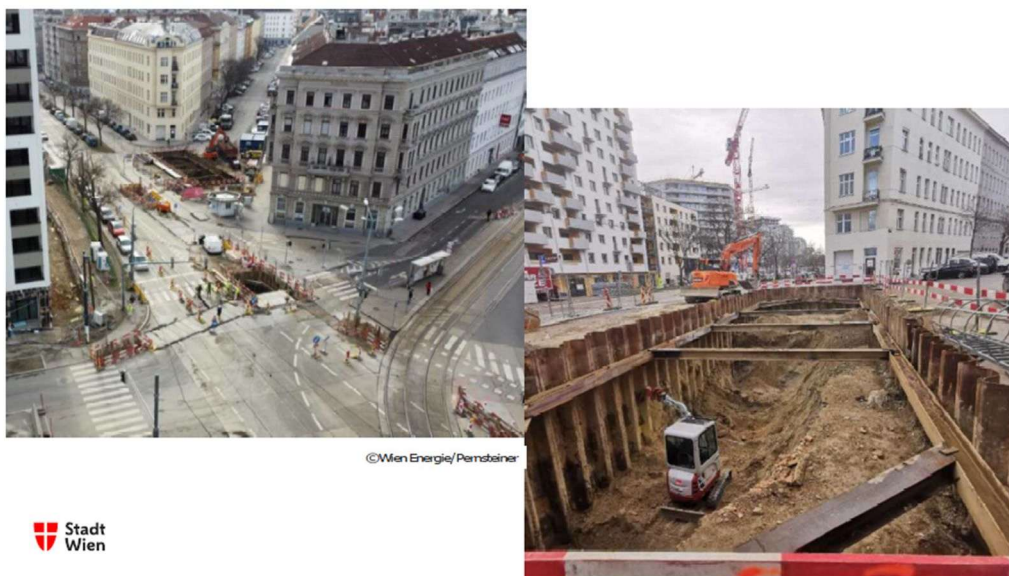
市街地で進む地域熱供給のネットワーク拡張工事の様子
