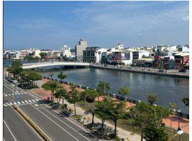
午前中の台南運河（上下水道局撮影）
