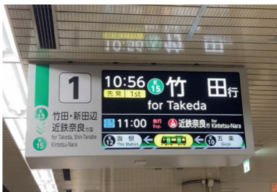
地下鉄烏丸線列車案内表示設備の更新・新設
