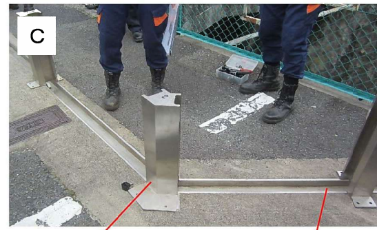
C 支柱 パネル設置用溝
