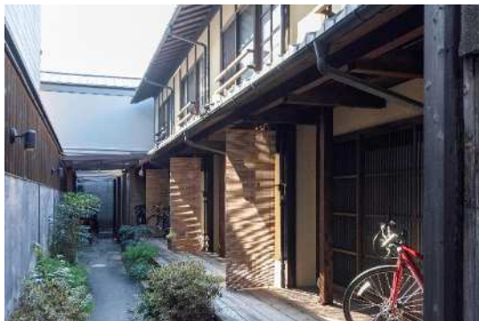
改修後の長屋
