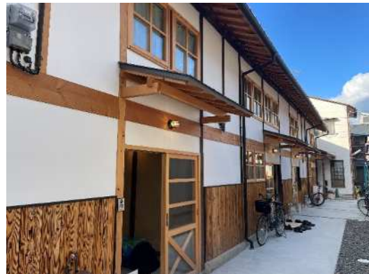
改修後の外観
