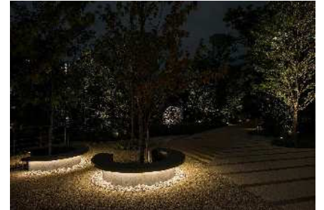
ベンチなど人が集まる憩いの場には、夜間も安心して過ごせる明るさがあるとよい。ベンチがある場合には、ベンチの下に照明器具を設置することで床面の明るさが確保でき、また光源が直接見えないためグレアも防げる。
