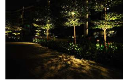
幹にスポットライトを設置して枝越しに地面を照らしている事例
