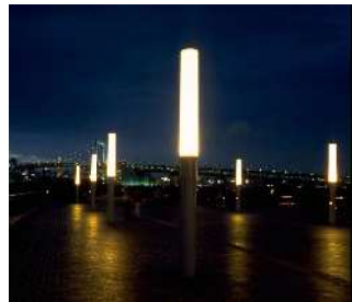
③発光型のポール照明 照度を確保するだけでなく、光るボール自体がアイキャッチになる。生活の中のアかりとは異なり、都市のインフラとして整備される。明る過ぎるものは発光部分の輝度が強くてグレアになるため、適度な明るさのものを選ぶとよい。
