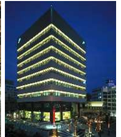
窓際の天井のライトアップが窓明かりに統一感をつけている事例
