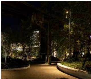
①ボールスポットライト ボールにスポットライトを設置したタイプで光が欲しい場所を的確に照らすことが可能。スポットライトが横向きに設置されていると、通行人にグレア（不快なまぶしさ）を与えてしまうのでなるべく下に向ける。
