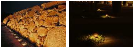
鉛直面を照らすことで、空間の明るさ感が向上する。 護岸では、安全な通行のためにボード照明で足元に光を配置するとよい。
