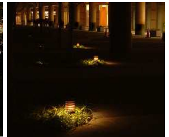
⑥全方向照射タイプの低ポラード照明 高さの低いポラード照明（30センチ以下）は日中に器具の存在を目立たせたくない場所や、あまり明るさが必要なく足元だけを照らしたい場合に適している。
