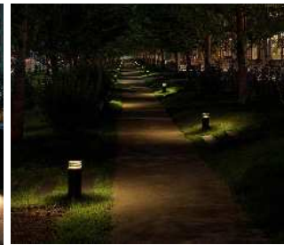
⑤全方向照射タイプのポラード照明 全方向照射タイプのポラード照明は、器具の周辺を全体的に照らしたい場合に適している。発光タイプはグレアになりやすいため、遮光ルーバー付きを選ぶとよい。器具の高さは30～100センチ程度が一般的で、場所のスケールに合わせてサイズを選定する。
