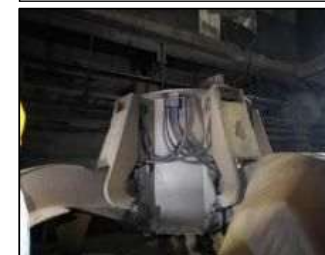
⑨ クレーンバケット（掴む部分）【設備】 油圧モーターやシリンダー、 電気ケーブルが焼損している。
