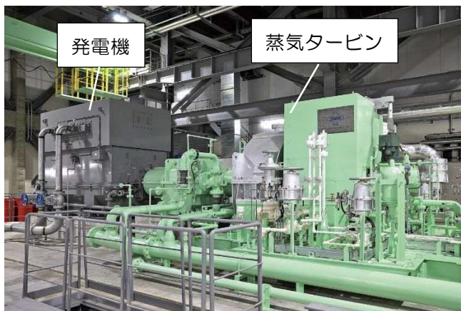
蒸気タービン発電機の例（南部CC）
