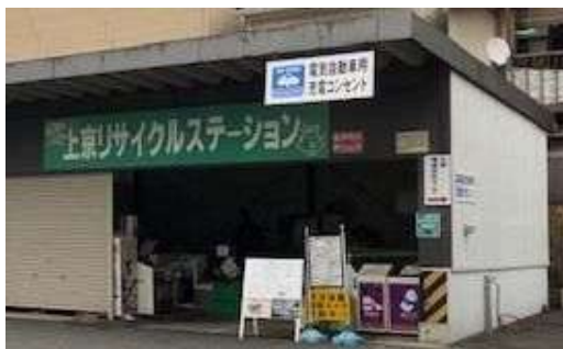
資源物回収拠点の例 (上京リサイクルステーション)
