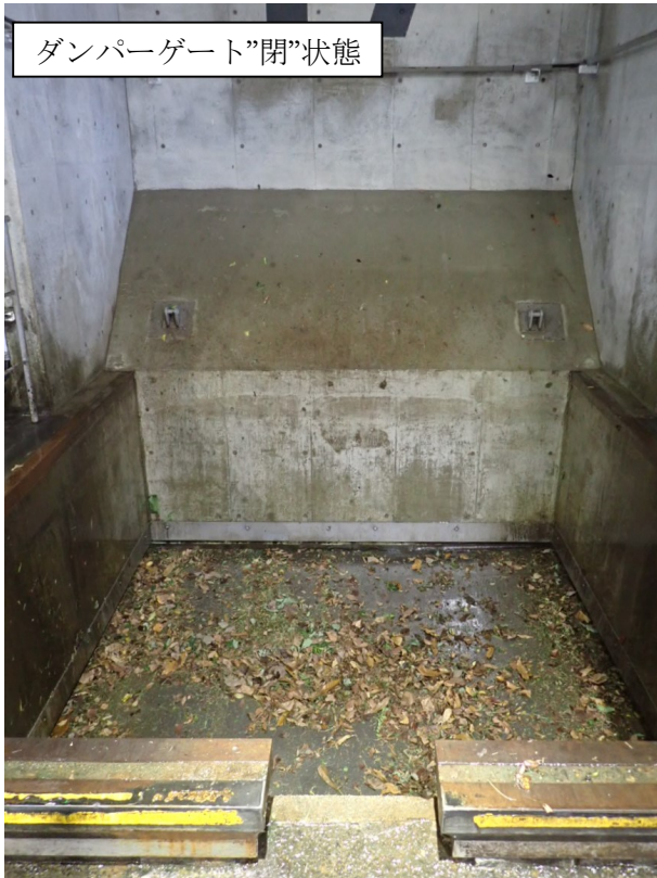
写真② プラットホームからダンパーゲートを見下ろした様子
