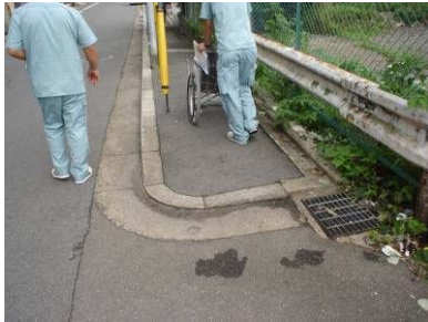
道路調査風景
