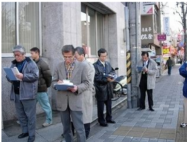
道路調査風景
