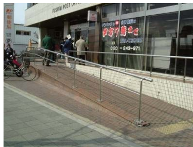
道路調査風景
