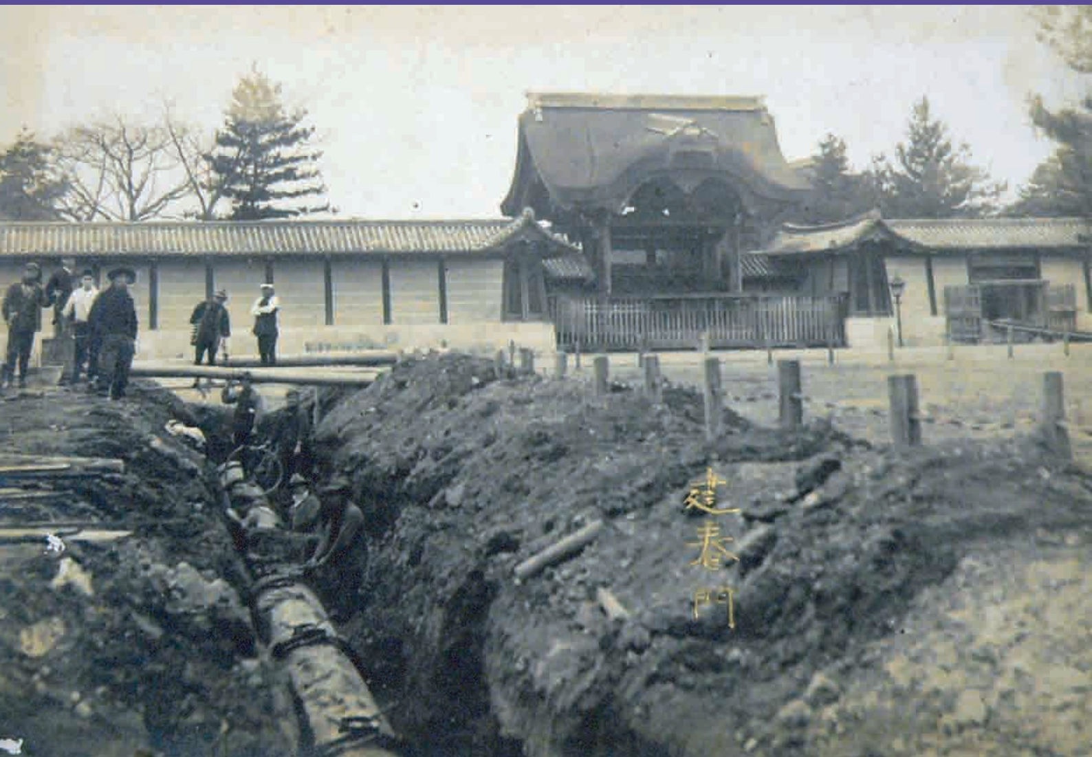
京都御所南東側建春門前の鉄管敷設工事 明治44(1911年)2月21日撮影 堀真澄 田邊家寄託資料
