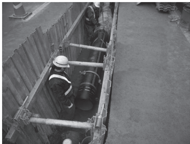
水道管路の工事の様子
