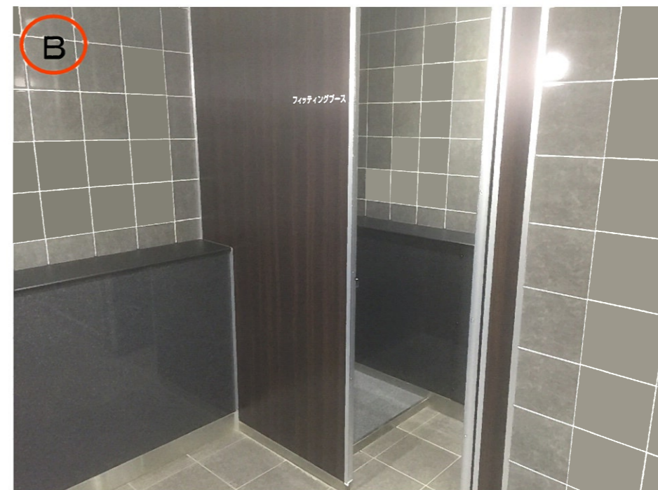
(フィッティングブース事例[北大路駅女子トイレ])
