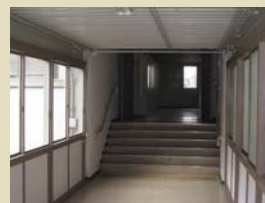
段差のある連絡通路
