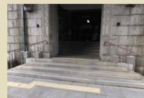
本庁舎東側の入口
